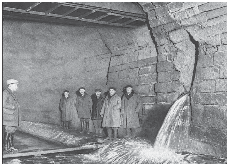
На порубіжжі між площами Голуховських та Краківською. Полтва на повороті між площею Голуховських та Краківською. Збоку, на певній висоті, ми бачимо великий отвір. Це головне сполучення всіх каналів та стоків від Краківської площі з руслом Полтви. Рясний потік води з нечистотами викликає під землею величезний шум, наче біля водоспаду. Банкетка в цьому місці постійно залита і непридатна для проходження. У разі чого доводиться бродити по коліна. Інженери та робітники під час робіт і перевірки склепіння приносять із собою дошки, щоб з їхньою допомогою перейти на протилежний бік. (Фотогр. ред. Данилюк)
